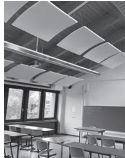
Klassenzimmer nach der akustischen Optimierung durch den Einbau von Decken-Absorberelementen.
