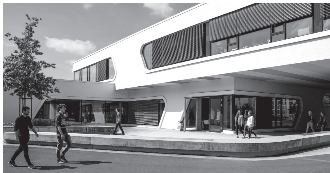
Die FOSBOS in Neu-Ulm wurde 2014 saniert und erweitert.
