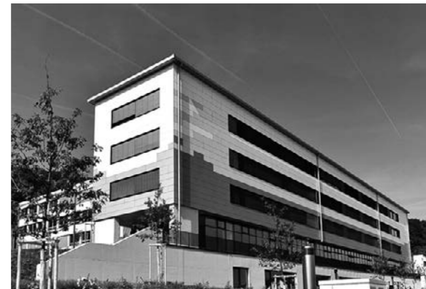
Der Neubau des Staatlichen Beruflichen Schulzentrums Kelheim wurde im September 2013 bezogen.
