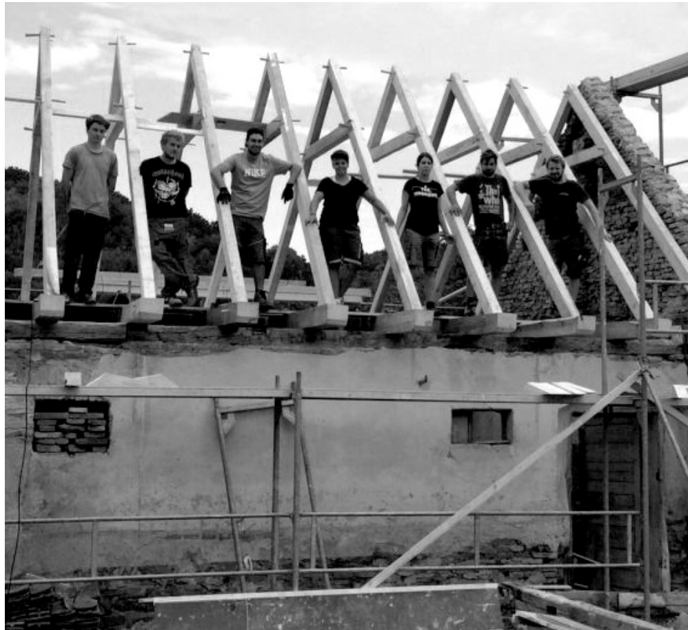
Straßenbauer, Bauzeichner, Maurer und Zimmerer arbeiten gemeinsam am neuen Dachstuhl.
