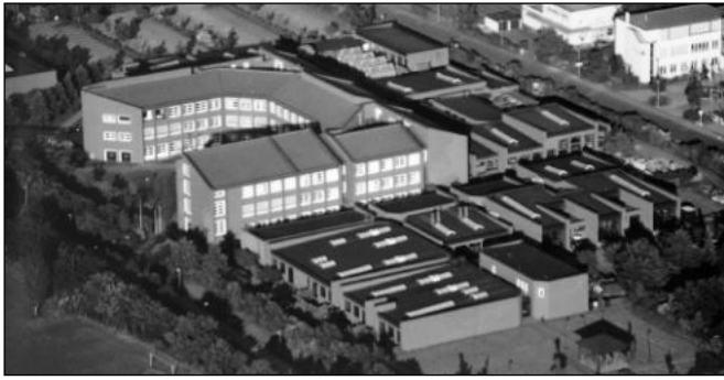
Aus der Vogelperspektive wird die Gliederung von dreigeschossigem Klassentrakt und ein-geschossigem Werkstatttrakt deutlich.
