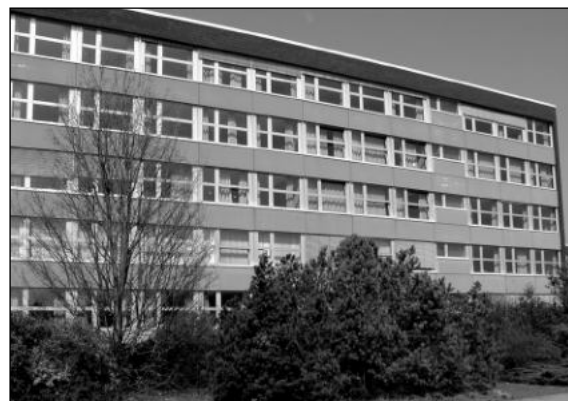
„Keine architektonischen Klimmzüge nach außen“: Die Graf-Stauffenberg-Schule in der Kloster-Langheim-Straße.
